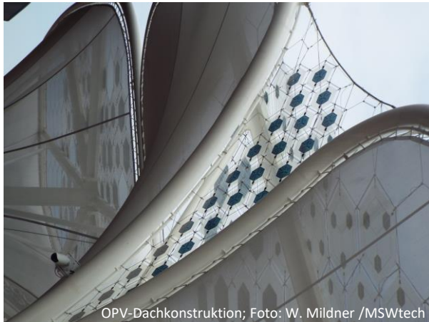
OPV-Dachkonstruktion; Foto: W. Mildner /MSWtech
