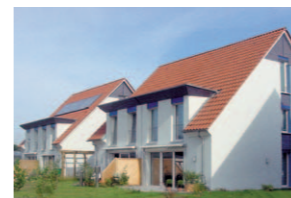
▶ Passiv-Häuser in Nürnberg-Wetzendorf, Planung: Meyer & Schulze Darup
