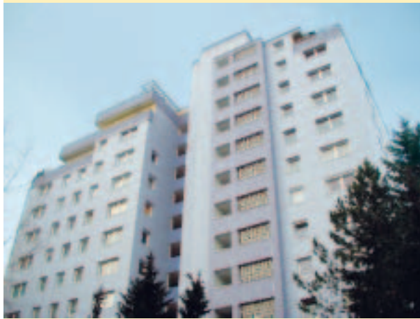
Bild 16: Gebäude aus den 70er Jahren mit sanierter Fassade
