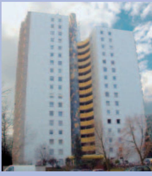
Bild 34: Gebäude von 1976 mit neuer Vorhangsfassade und verbessertem Wärmeschutz
