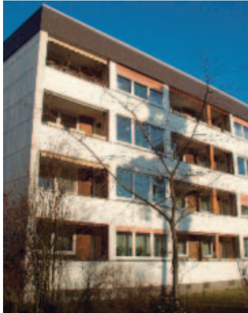
Bild 31: Unsaniertes Gebäude von 1960
