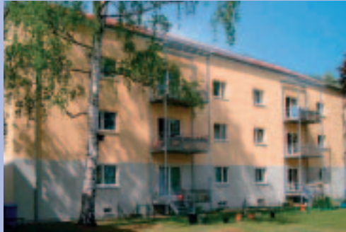
Bild 33: Gebäude der WBG-Nürnberg zum 3-Literhaus saniert (Quelle: Architekt Dr. Schulze Darup)
