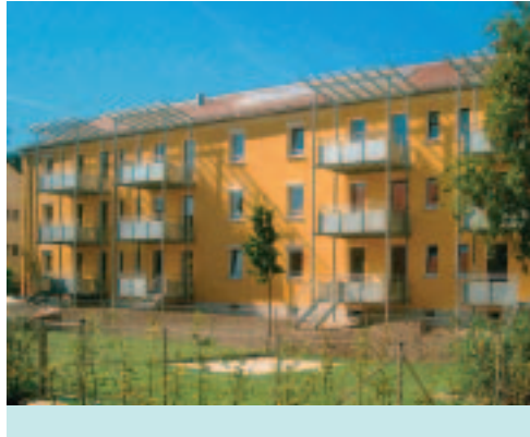
Bild 7: Saniertes Mehrfamilienhaus der wbg-Nürnberg (Quelle: Schulze Darup)
