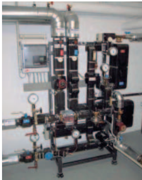
Bild 25: Fernwärmeübergabestation (Quelle: Estw)
